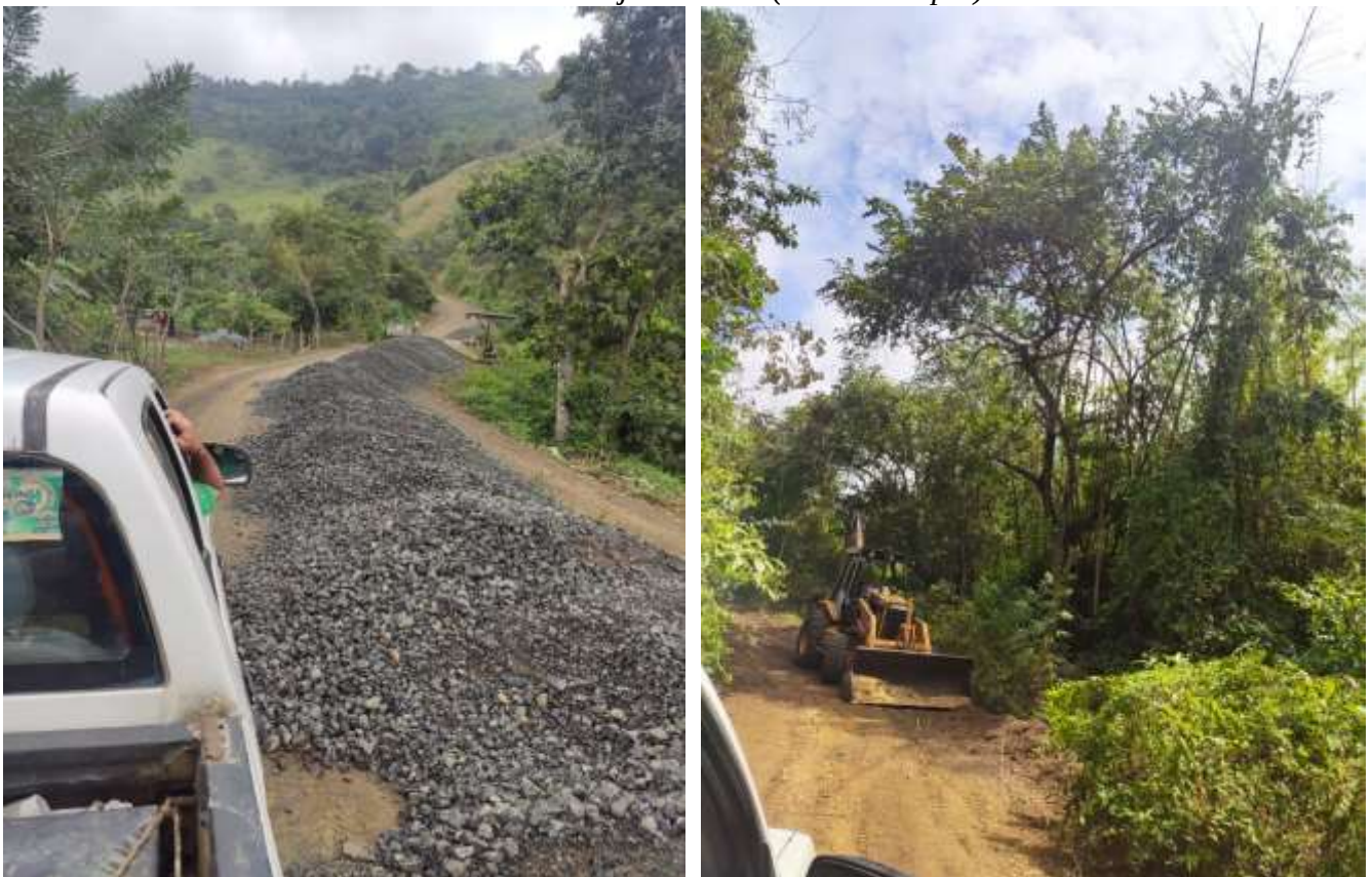
Ilustración 13 Vías en mejoramiento (Fuente Propia)
