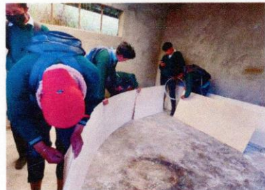
Construcción del panel circular
