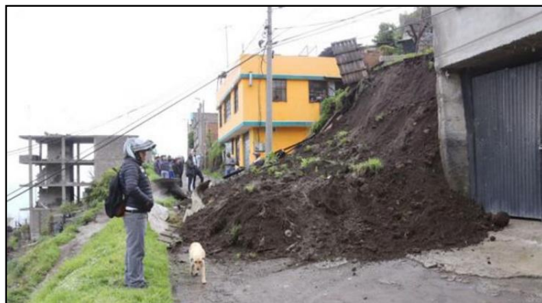
Foto No. 15 Colapso de muros y deslizamientos en Atucucho por lluvias
