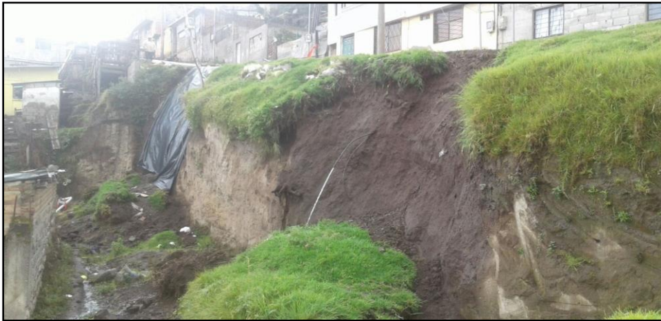
Foto No. 8 Rotura de Tubería Zona San Jacinto, Barrio Atucucho
