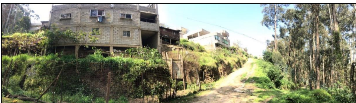
Foto No. 7 Sector Laderas del Cisne, Barrio Atucucho
