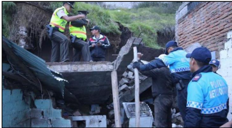
Foto No. 17 Caída de un muro destruye vivienda.
