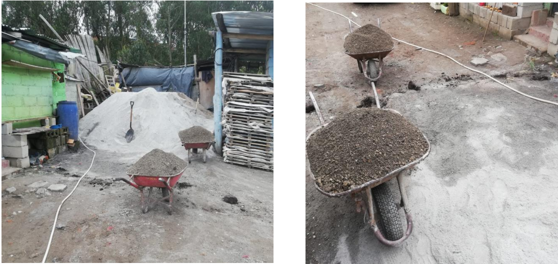
Ilustración 16. Obtención de los agregados para el bloque
