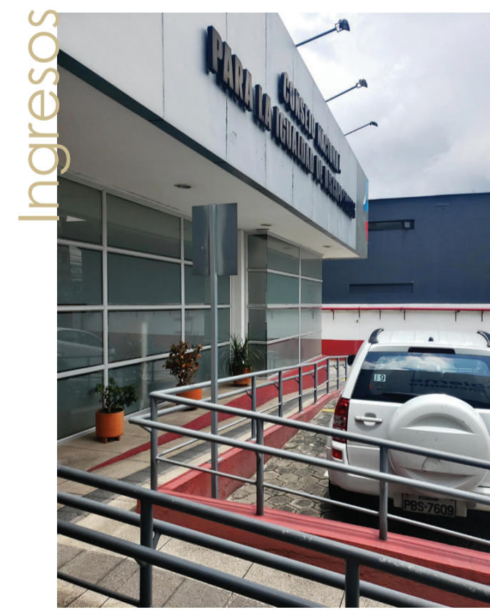
Ingresos Rampas externas sin cubiertas y estancias para uso vehículo privado.
