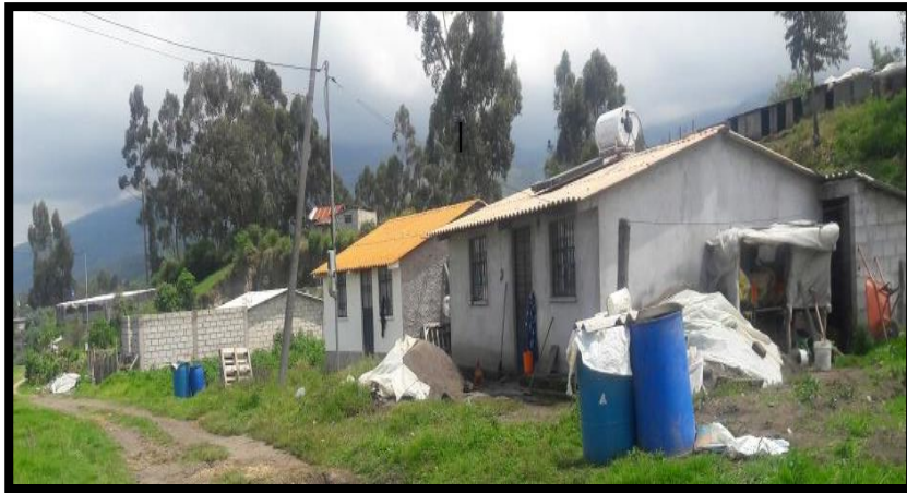
Fotografía 10. Cubiertas de las viviendas. Fotografía: López Raúl, 2016
