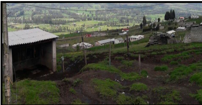
Fotografía 6. Cubiertas de las Viviendas. Fotografía: López Raúl, 2016
