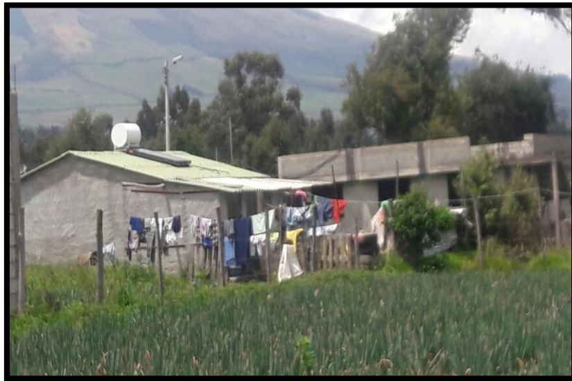
Fotografía 11. Estado de Viviendas. Fotografía: López Raúl, 2016
