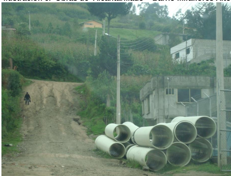
Ilustración 6. Obras de Alcantarillado – Barrio Miraflores Alto
