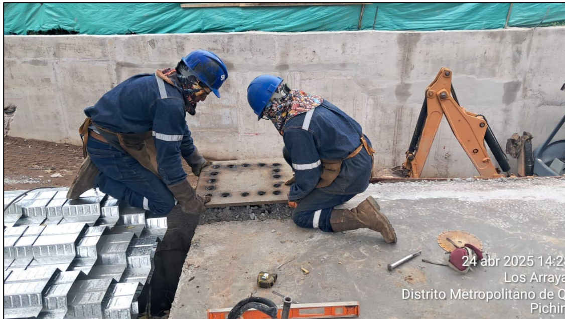
Colocación de placas de apoyo de estructura metálica
