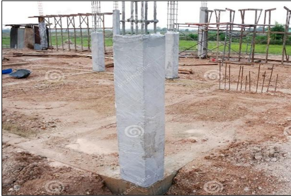
Columna de hormigón armado
