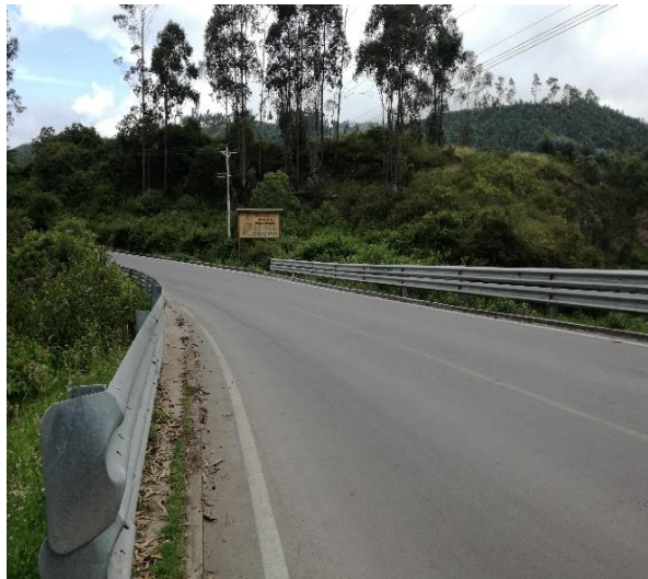
Foto 3. [Fotografía de Marco Morejón]. (Límite entre la parroquia Angochagua y la parroquia La Esperanza, 2019). Vía nueva de acceso Ibarra – Zuleta - Olmedo hacia la parroquia rural de Angochagua
