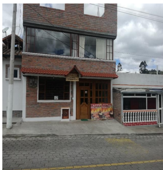
Foto 26. [Fotografía de Marco Morejón]. (Comunidad Zuleta – Sector de estudio N°3, 2019). Emprendimiento gastronómico al margen de la vía Ibarra – Zuleta – Olmedo- Uso vivienda y comercio.
