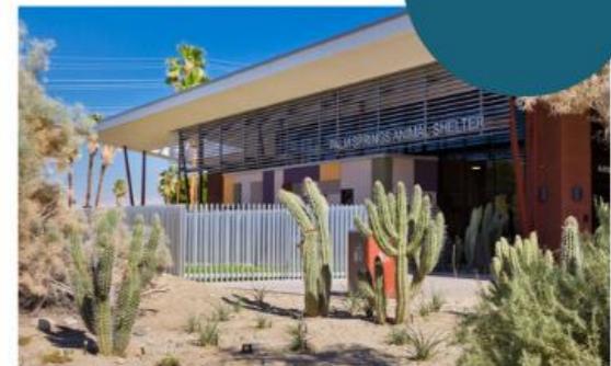
Centro de Cuidado de Animales de Palm Springs / Swatt | Miers Arquitectos
