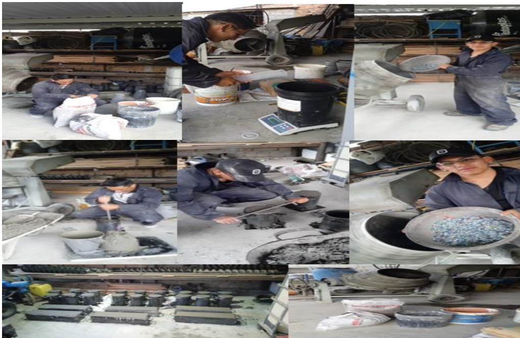
Ilustración 4.2 Desarrollo de los cilindros y vigas con los diferentes porcentajes de botella triturada en la mezcla
