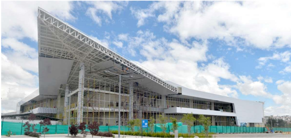
Figura 60: Nuevo Centro de Convenciones Bicentenario 17 . (EPMGDT, 2017)
