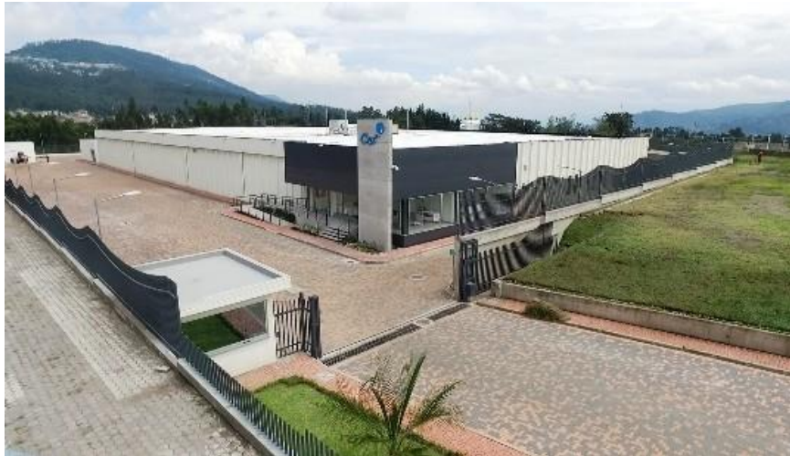
Figura 59: Data Center Quito. 16 (CNT, 2016)
