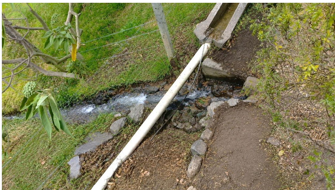
Figura 19 Condiciones de la conducción de agua y área susceptible de adecuación técnica en el ojo de agua
