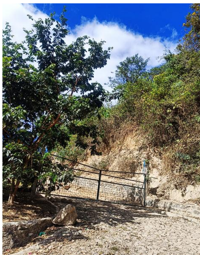
Figura 18 Condiciones de maniobra para ingreso de personal, insumos y maquinaria
