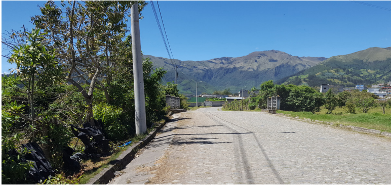
Estado actual de la vía
