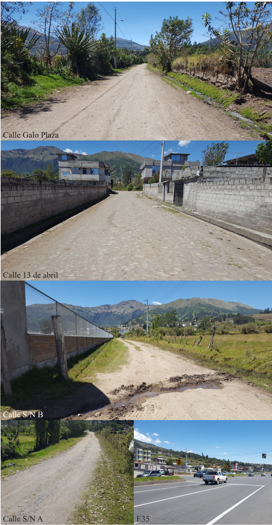
Figura 126: Fotografías de la infraestructura vial del sector de estudio Fuente: Elaboración propia
