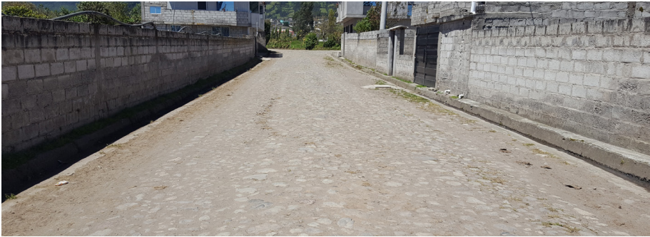
Estado actual de la vía
