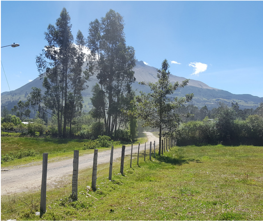
Estado actual de la vía
