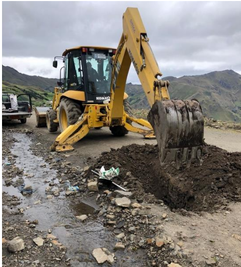
Imagen 4: Excavación para obtención de suelo natural
