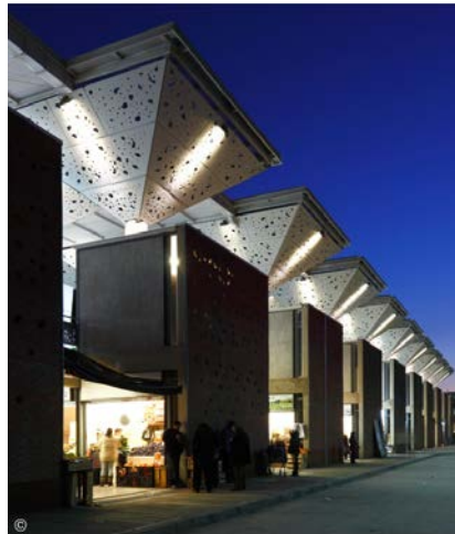
Fotografía 9: Vista Nocturna del Mercado Tirso Molina – cubiertas
