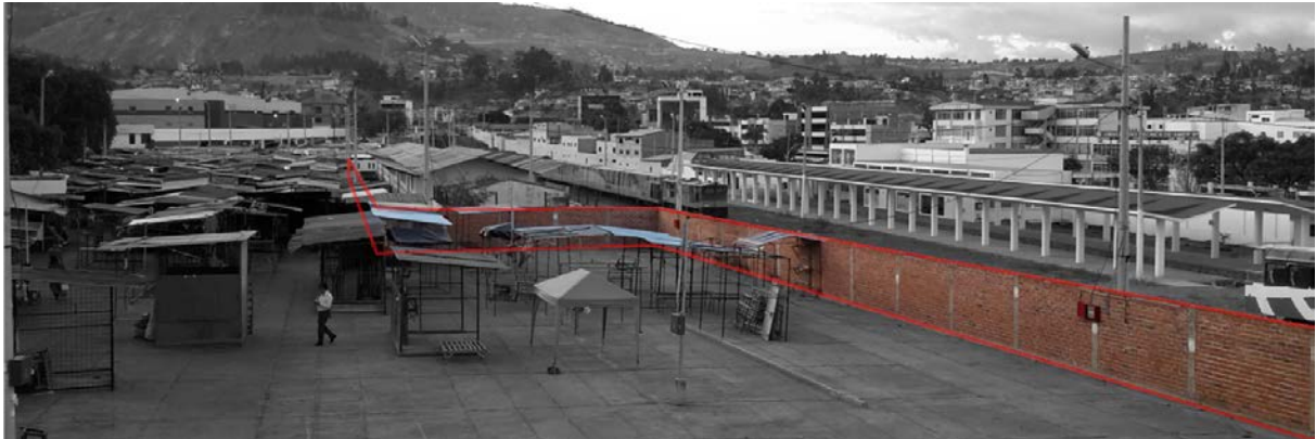
Fotografía 4: Muros ciegos - desconexión
