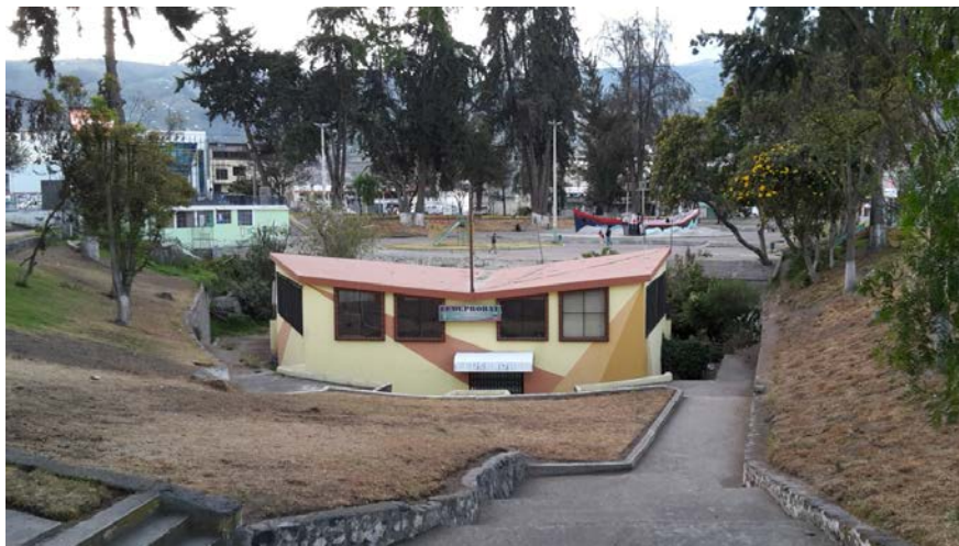
Fotografía 3: Estado actual del Parque Laguna
