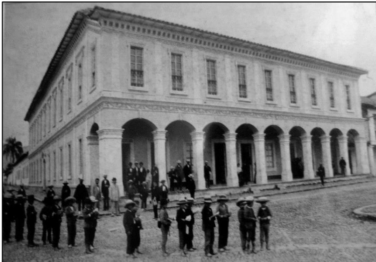
Figura 19 Colegio Teodoro Gómez de la Torre, 1974
