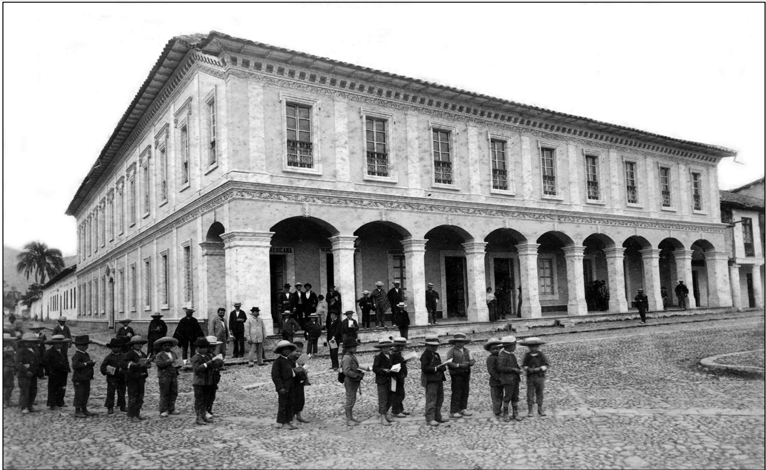
Figura 8 Antiguo Colegio Teodoro Gómez de la Torre, 1606
