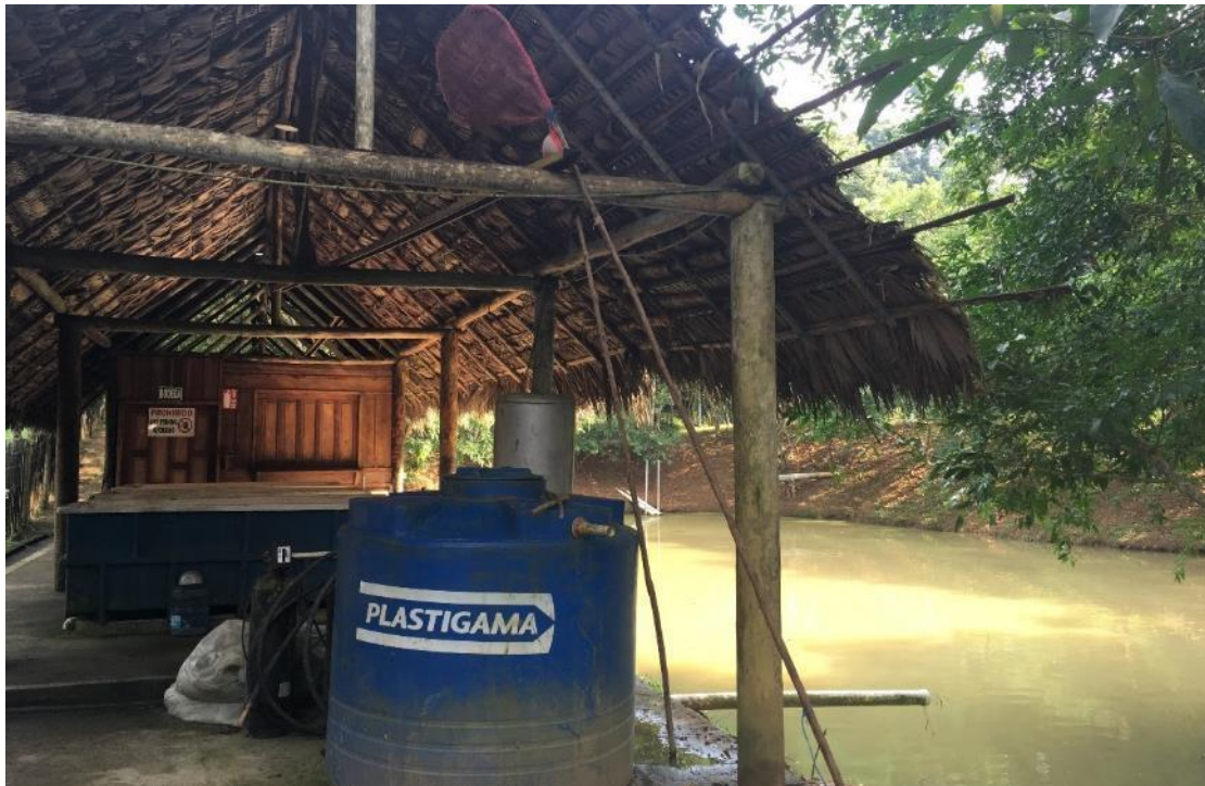
Fotografía 18. Sala de máquinas de granja piscícola. Autoría Propia.
