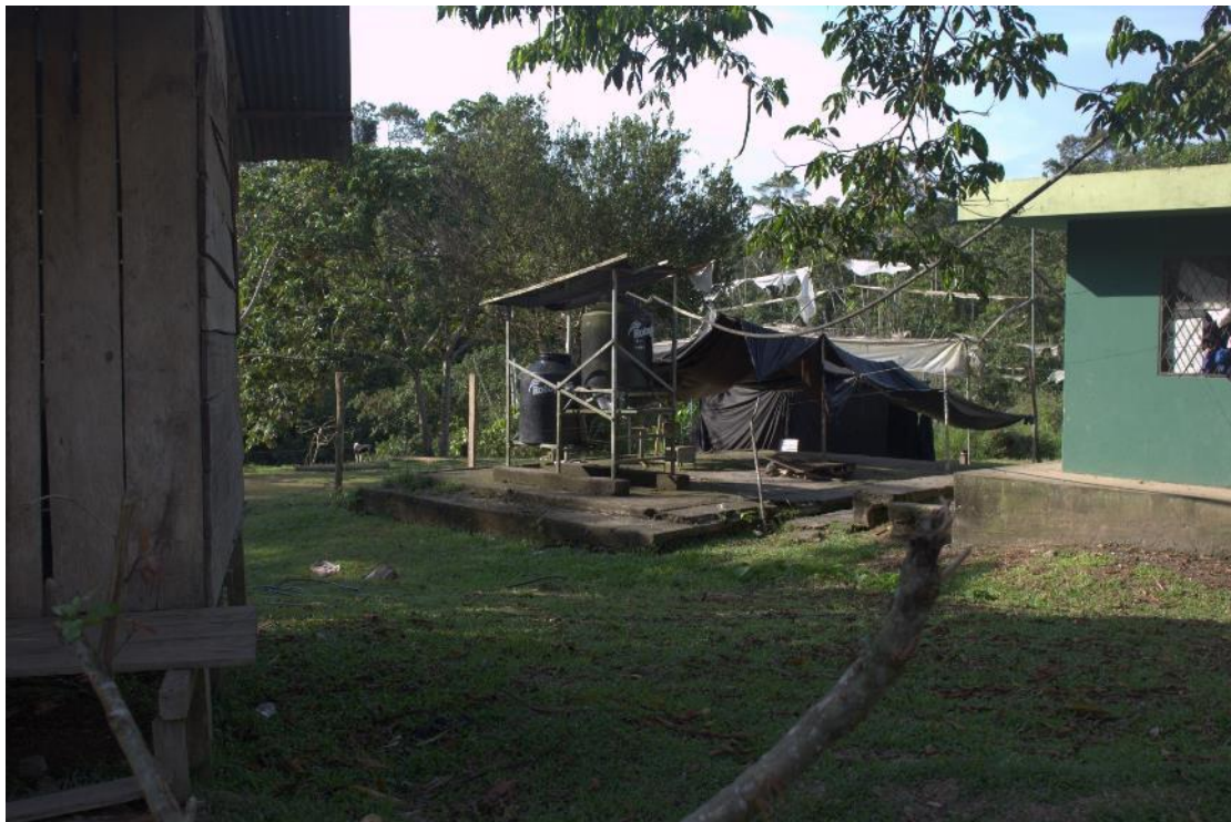
Fotografía 8. Sistema de recolección de aguas detrás de vivienda. Autoría Propia.
