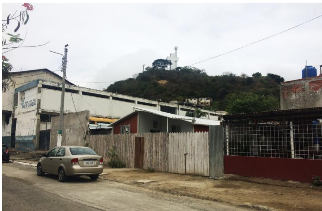
Ilustración 45 Vivienda entregada por MIDUVI no corresponde a la normativa municipal. Fuente: Elaboración propia, 2017
