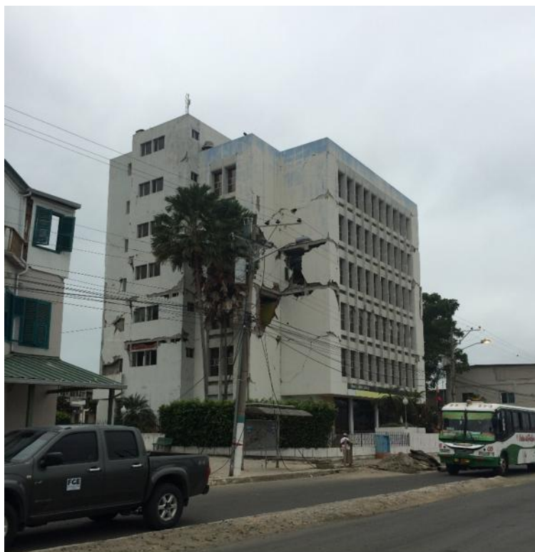
Ilustración 26 Situación posterremoto edificio Museo del Banco Central. Fuente: Elaboración propia, año 2016
