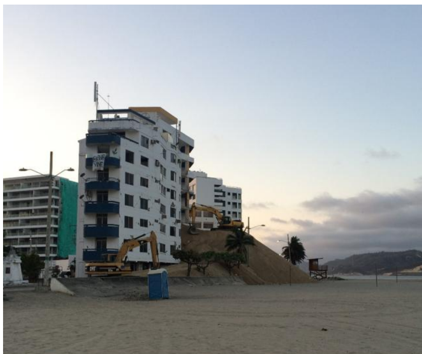
Ilustración 39 Edificio frente al mar en proceso de derrocamiento. Fuente: Elaboración propia. 2016
