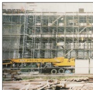
Ilustración 54 Construcción edificio Gifu Katayata (gifuprefecture.blogspot, 2007)
