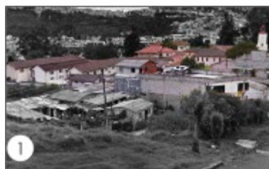
Ilustración 21 Muro Leprocomio (Ramires-Scacco 2022)
