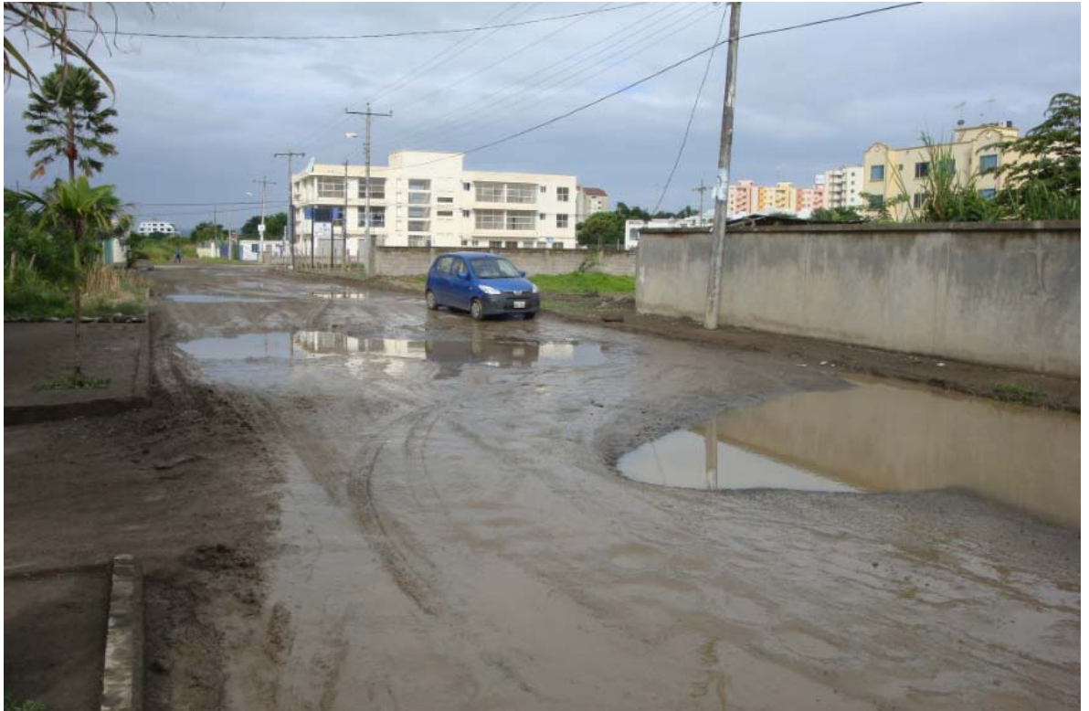
C22. Foto 43. Condiciones de la zona, acceso Calle Quinta
