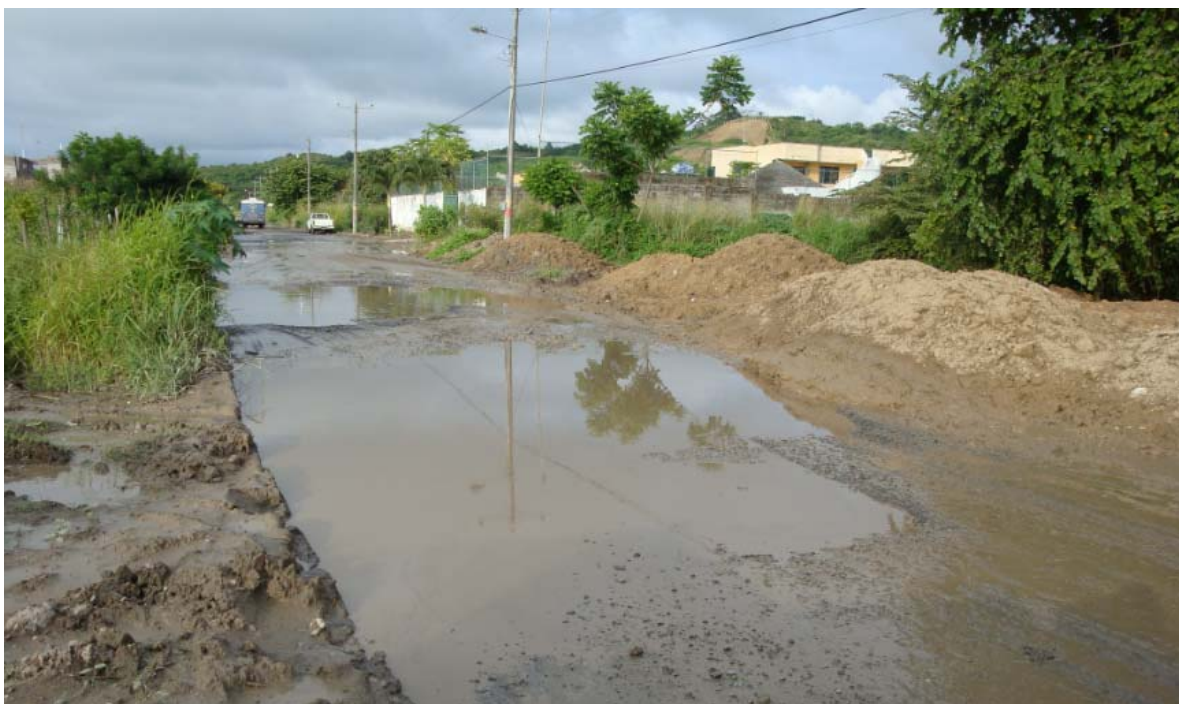
C1. Foto 1. Calle Quinta acceso a la Zona B, fotografía sobre el Estero.
