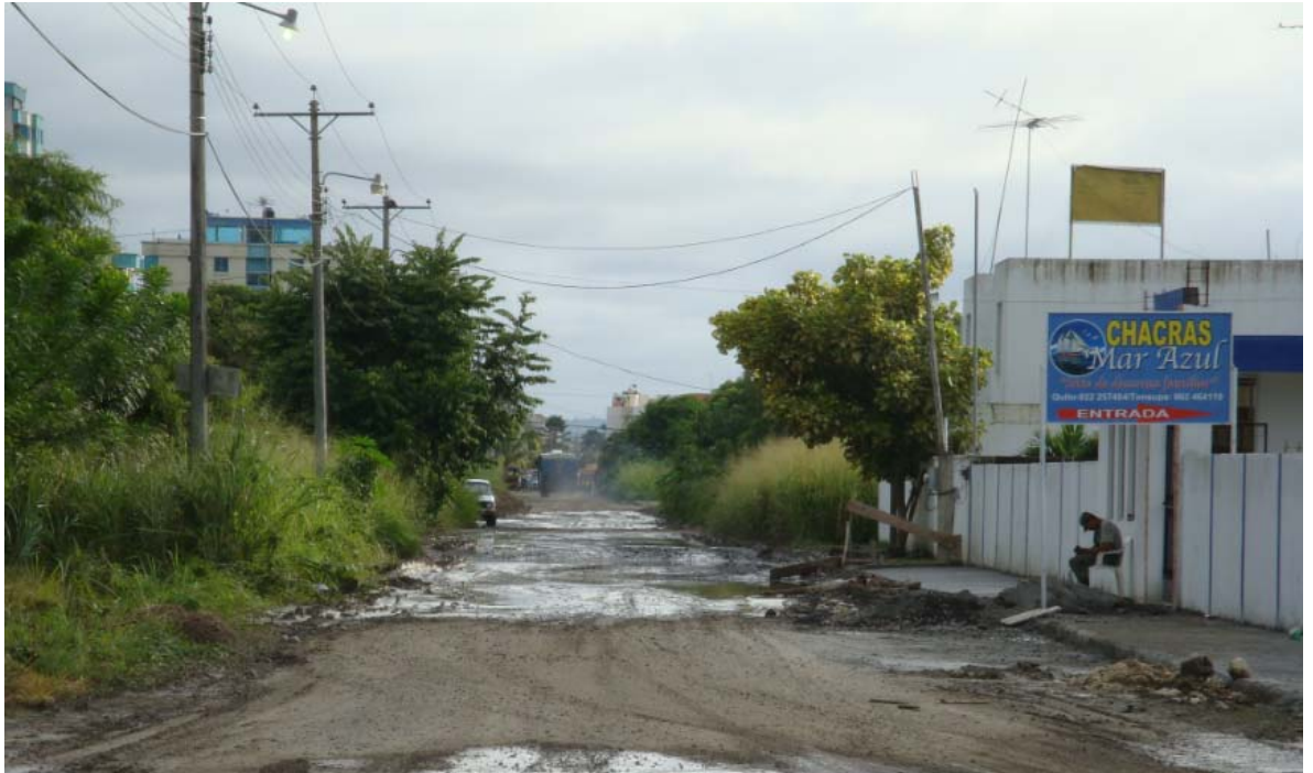
C5. Foto 9. Vista Frontal desde la intersección Av. E y Calle 26 hacia el Estero
