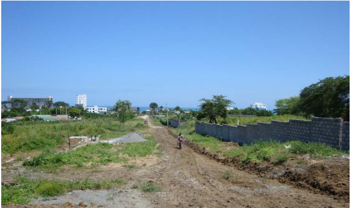
C20. Foto 39. Vista Frontal de la Av. E desde la intersección con la Calle 25 límite este
