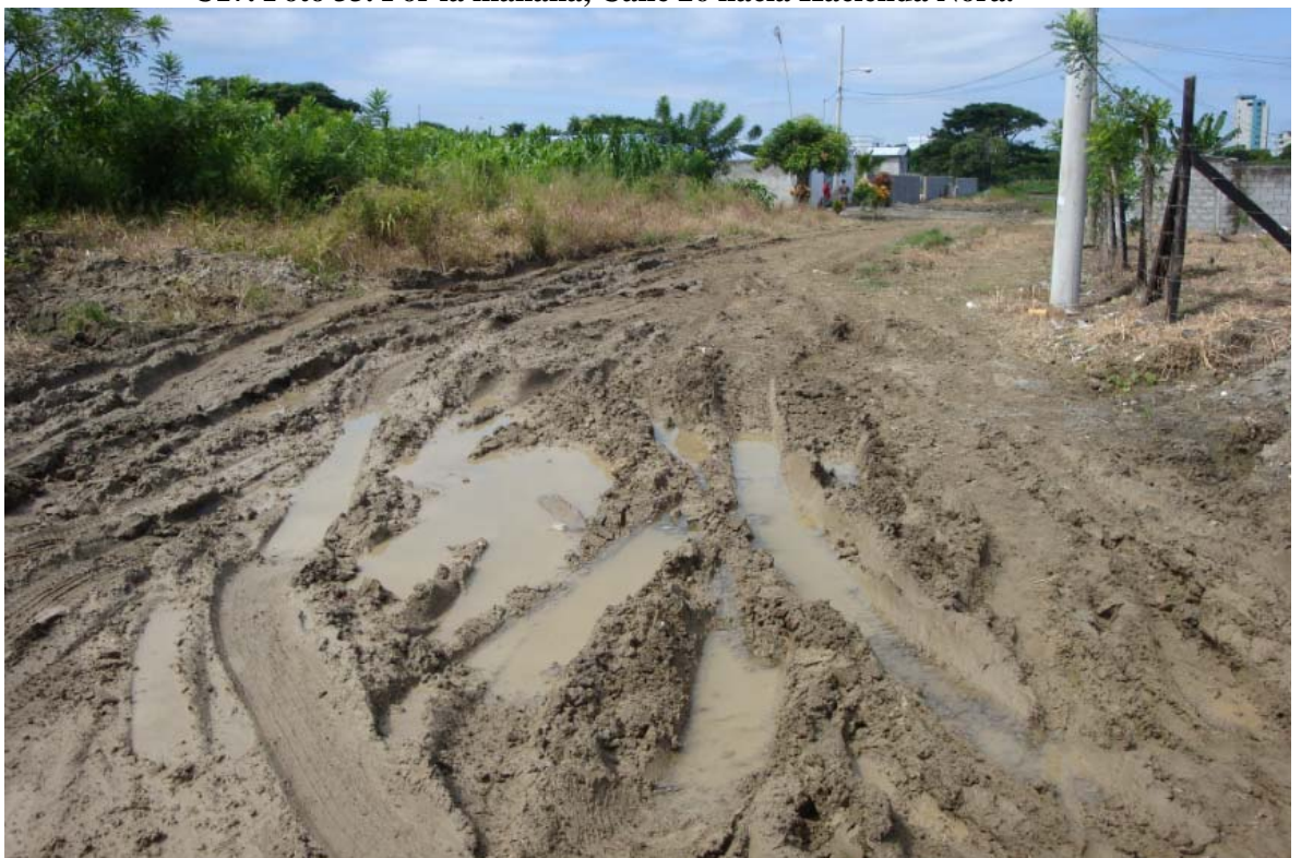
C17. Foto 34. Av. E y Calle 25 hacia el Estero
