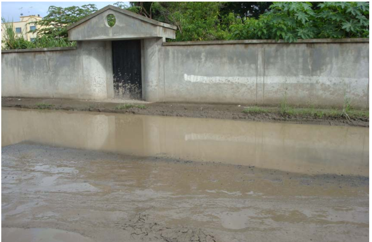
C22. Foto 44 Acumulación de Agua Lluvia en la Calle Quinta (5)
