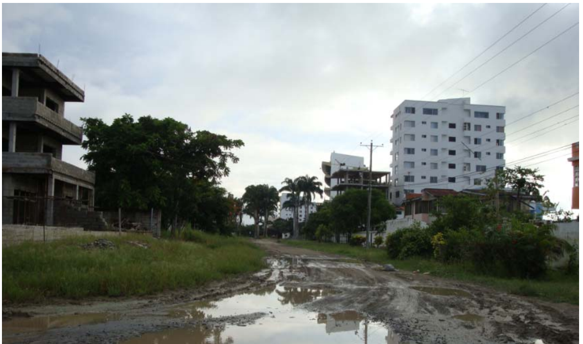
C9. Foto 18. Av. E y Calle B problemática con la evacuación de aguas lluvias.
