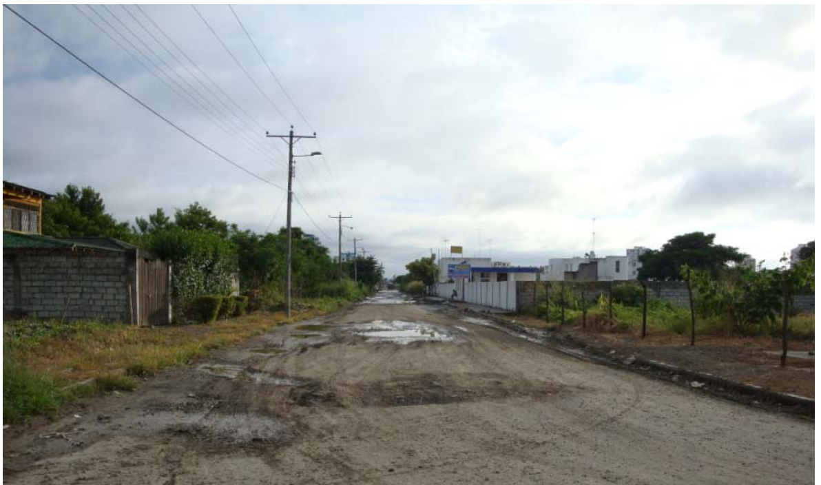
C4. Foto 8. Vista Frontal desde la intersección Av. E y Calle 26 hacia el Estero
