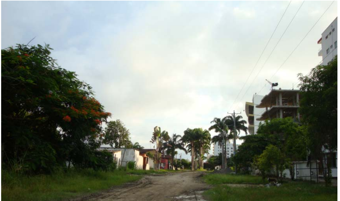
C11. Foto 21. Vista Calle B y Pasaje Público 10, Club del Pacífico.
