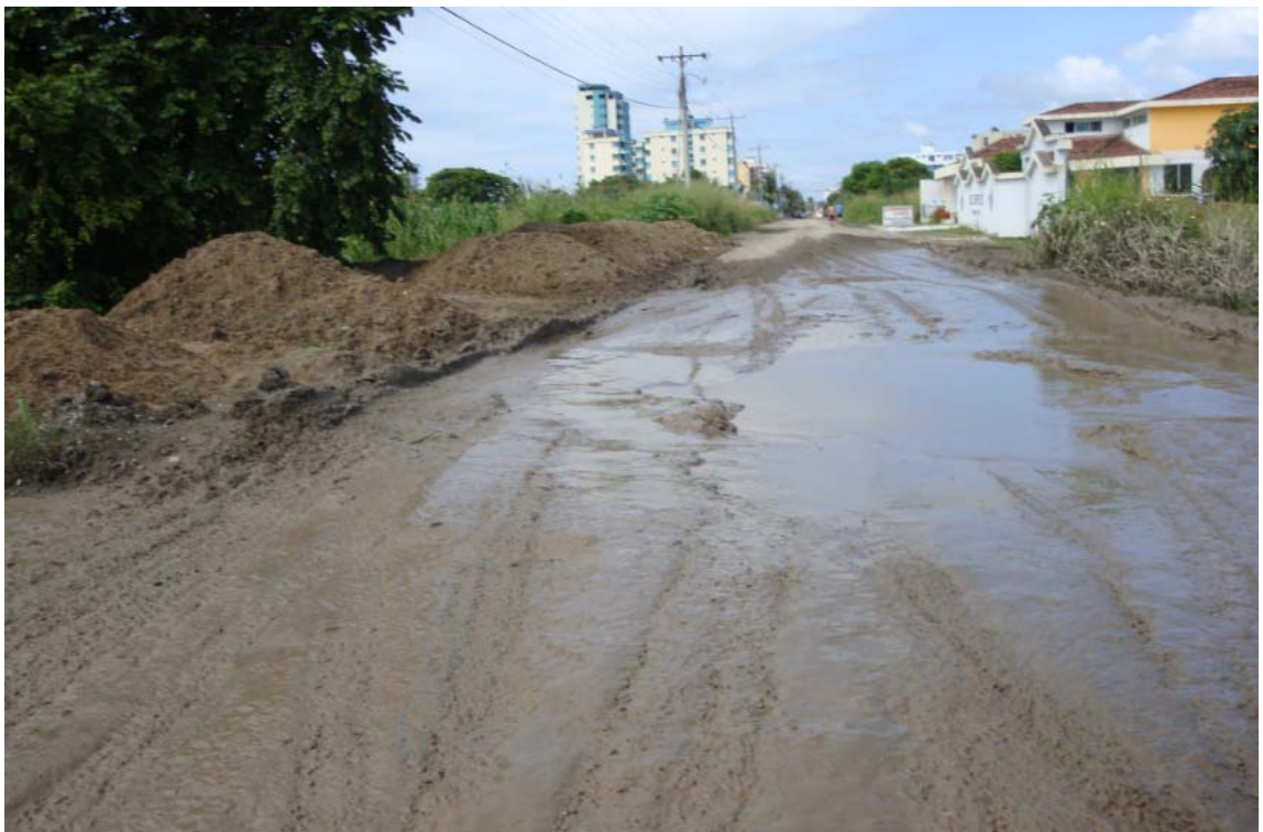
C16. Foto 32. Desarrollo de la Zona y acumulación de aguas lluvias.
