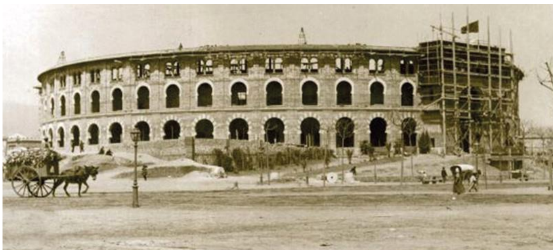
Ilustración 34. Construcción de la Plaza de Toros de Las Arenas (Ordoñez, 2022)
