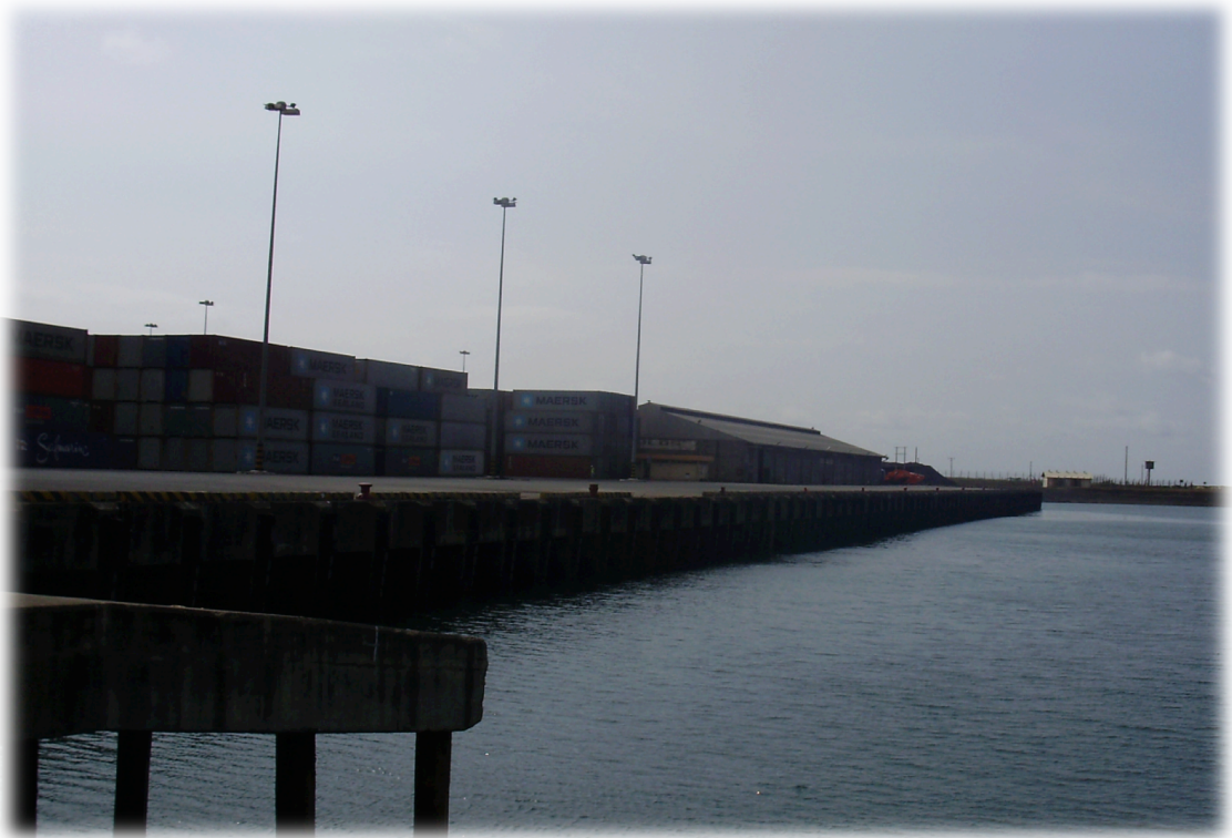
FOTO No. 12: MUELLE # 2 Y 3
