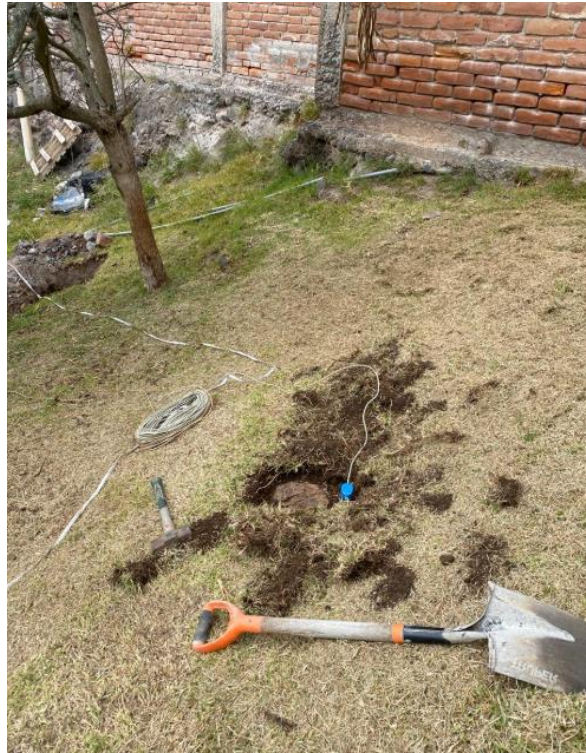
Imagen 6: Ensayo de Sísmica de refracción (Imagen: Ing. Renato Guamán)
