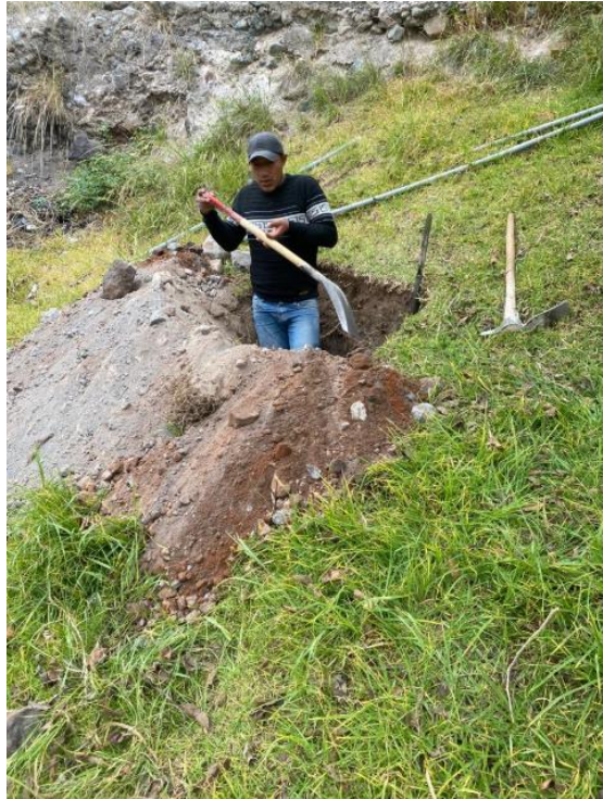
Imagen 4: Reconocimiento Geotécnico y toma de calicatas (Imagen: Ing. Renato Guamán)
