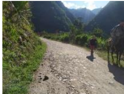
Imagen 2 Vía empedrada estado regular
