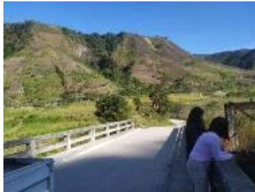
Imagen 3 Puente en buen estado
