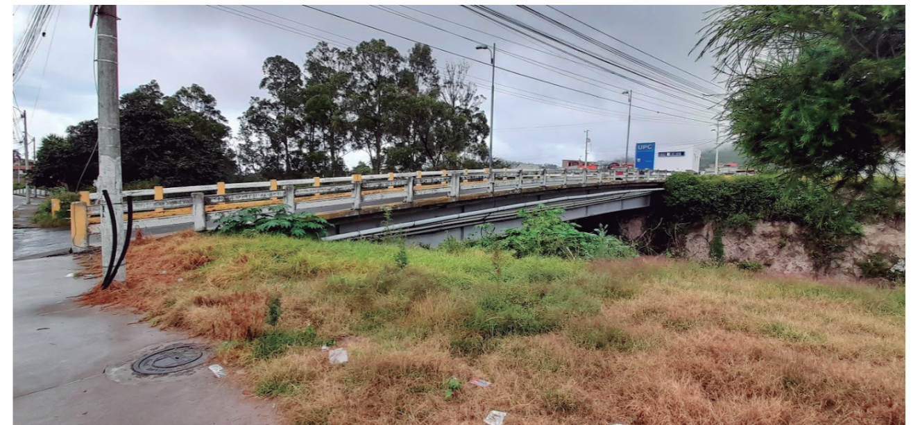
(Figura 266), Foto 2020 Puente "Tahuando".
