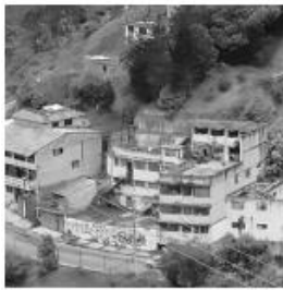
Condición 3: Muros de contención
