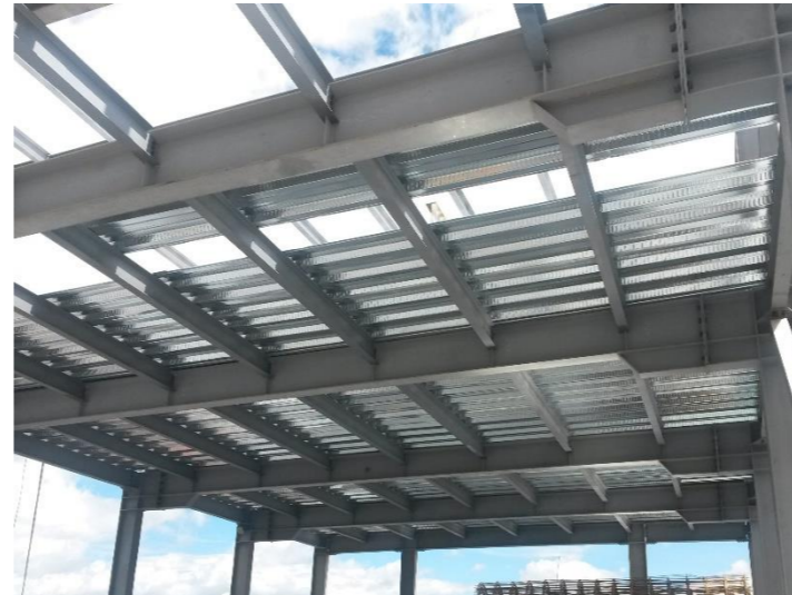
Figura 64: Estructura Metálica R2 Fuente: ingecivil
