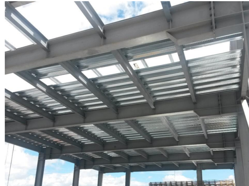
Figura 50: Estructura Metálica Fuente: Ingecivil
