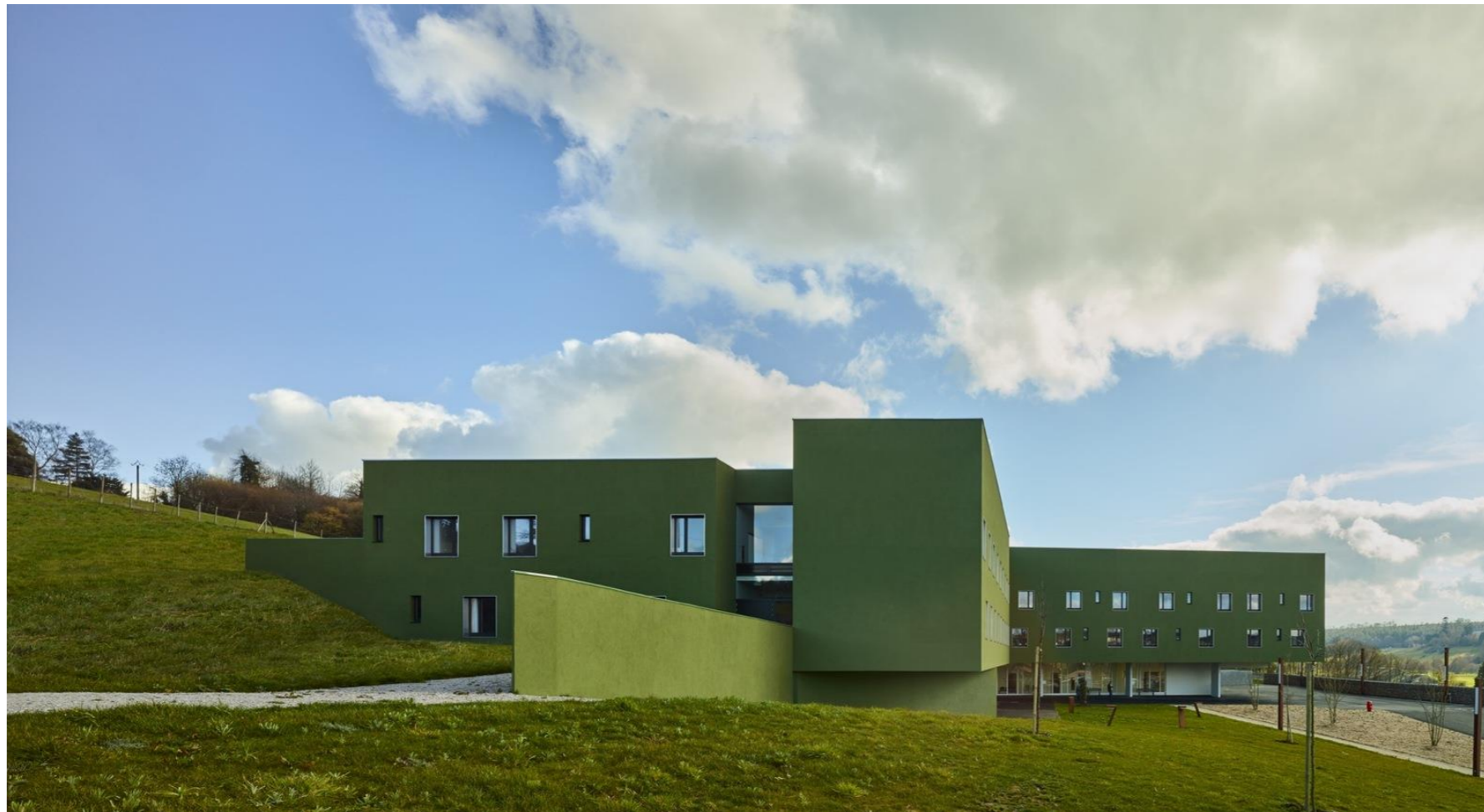
Figura 57: Fachada R2 Fuente: Plataforma Arquitectura
