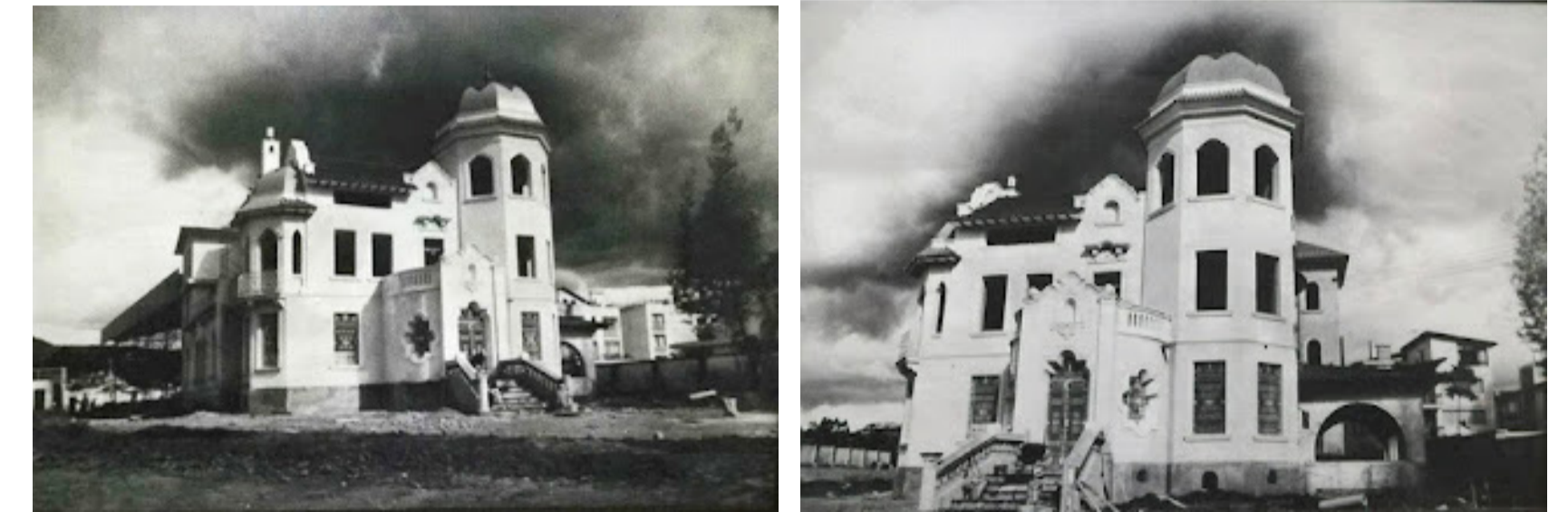
Fuente: Ladrillos de Quito, década de 1970.
