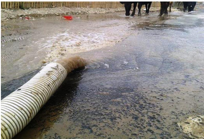
FOTO N°12: EVACUACIÓN DE AGUAS NEGRAS
