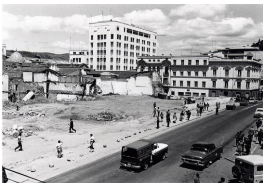
Imagen 45: Derrocamiento del antiguo edificio municipal luego de expropiarse los lotes aledaños, 1960s
