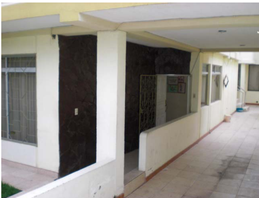
Foto N° 58: Pasillo de entrada
