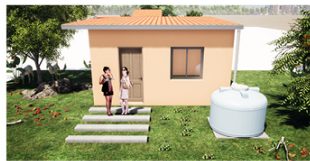
Imágen 65: Cisterna de agua lluvia anexa a la techumbre de vivienda (Avilés, M.; 2022)
