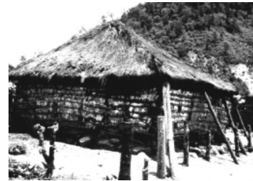
Casa de bahareque afectada por sismo Guatemala (Minke; 2001)
