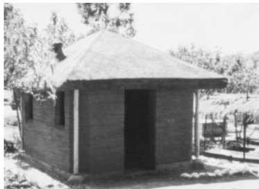
Vivienda antisísmica de tapial Pujilí, Ecuador 1989 (Minke, 2001)
