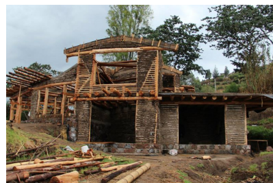
Casa de bahareque en construcción Tumbaco, Ecuador 2013 Fuente: David Lasso
