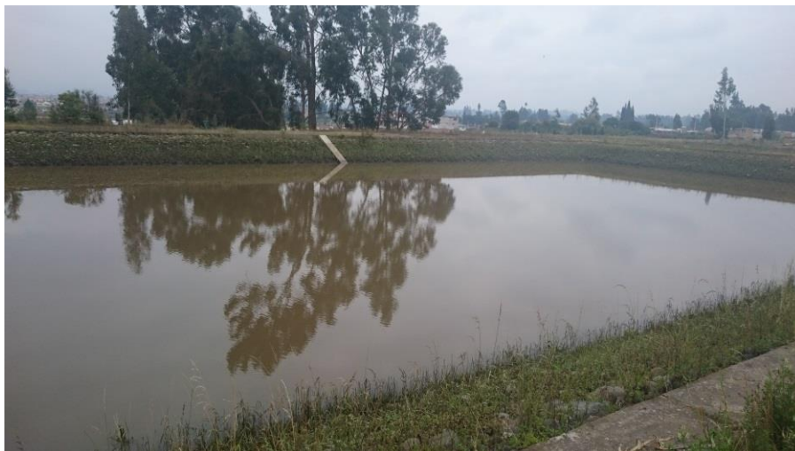
Reservorio para carga de agua
