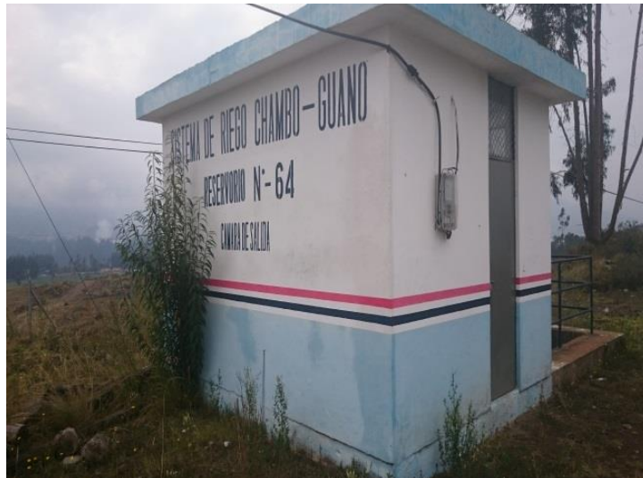
Cámara de control Reservorio # 64
