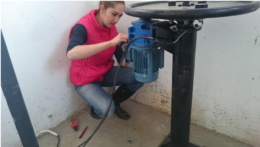
Acoplamiento a la válvula de distribución de agua
