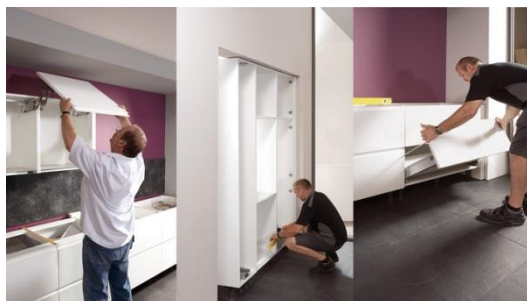
Figura 12: Servicios transporte, montaje e instalación
