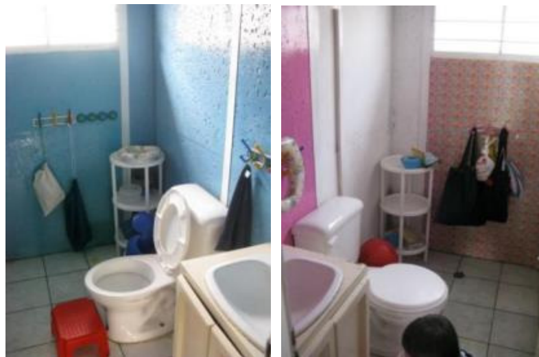
Fotografía 5: Sanitarios Guardería Saint Joseph.
