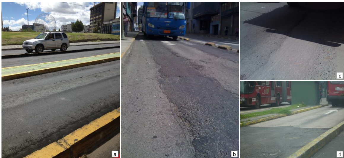
a. Av. Tarqui (Ecovía, agosto 2013) b. Av. 10 de Agosto (Trolebús, junio 2011) c. vía E28 (Tumbaco, agosto 2011) d. Av. 6 de Diciembre (Ecovía, febrero 2013)
