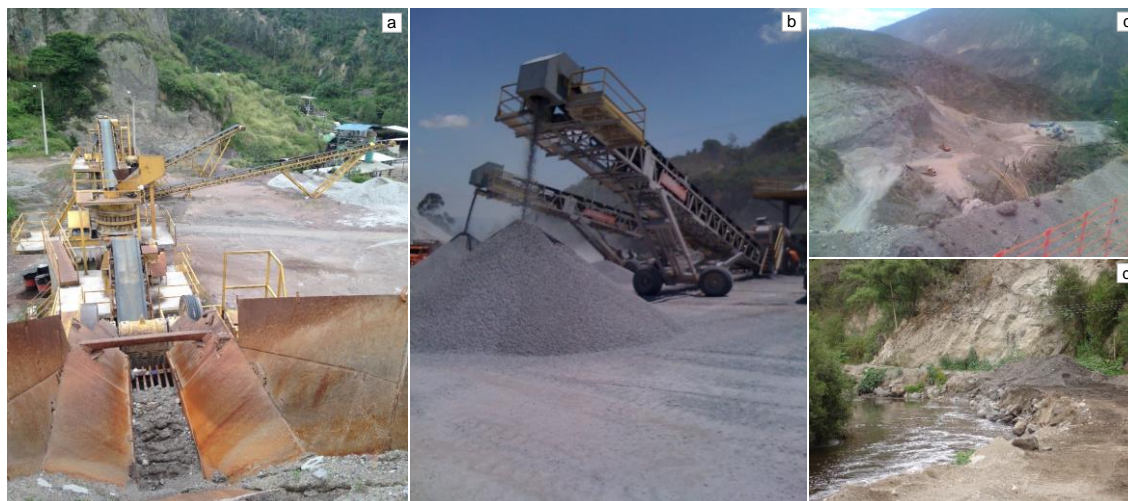
a) Trituradora en planta municipal b) Acopio en planta de Pifo c) Cantera en Guayllabamba d) Arena de río
