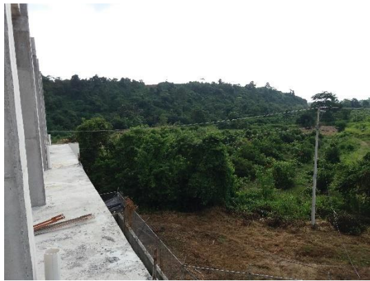
Edificio en construcción
