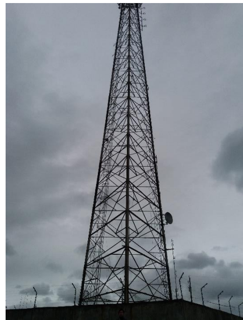
Gatazo 2 - Torre de Telecosta
