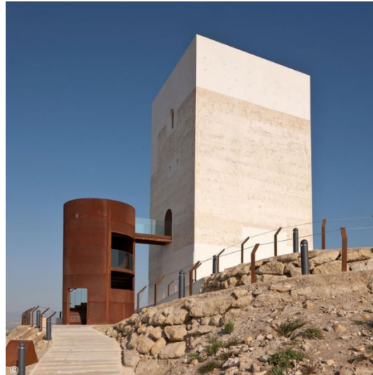
Figura 27: Restauración de la torre Nazari de Huercal-Overa, España. (Castillo-Miras arquitectos, 2010). Fotografía de Fernando Alda.
