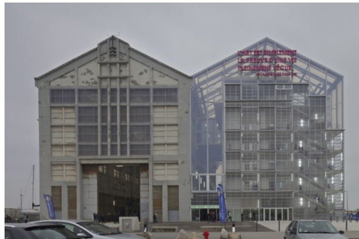
Figura 31: FRAC Dunkerque (Lacaton & Vassal, 2013). Fotografía de Philippe Ruault.
