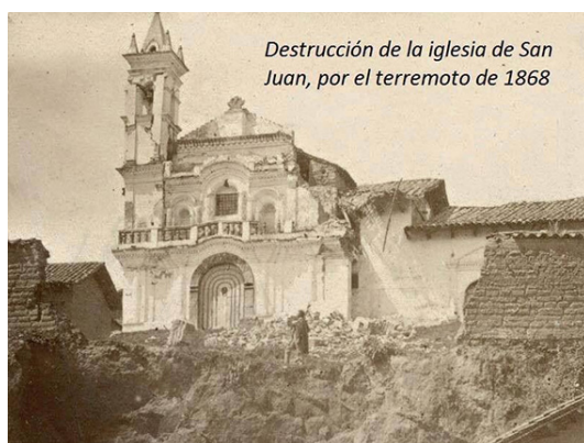
Figura 4: Destrucción de la Iglesia de San Juan, luego del terremoto de 1868. Fotografía S/A.
