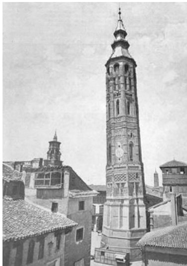
Figura 43: La Torre Nueva, Zaragoza (1870). Fotografía S/A. Recuperado de: https://www.almendron.com/blog/la-torre-nueva/
