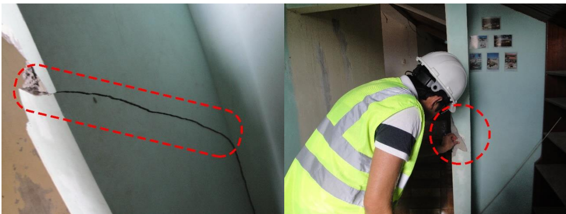
Figura 97: Muros Fuertes: Flexión Fuera del Plano del Muro (ENDE) – “Vivienda del Sr. Walter Santos”.
