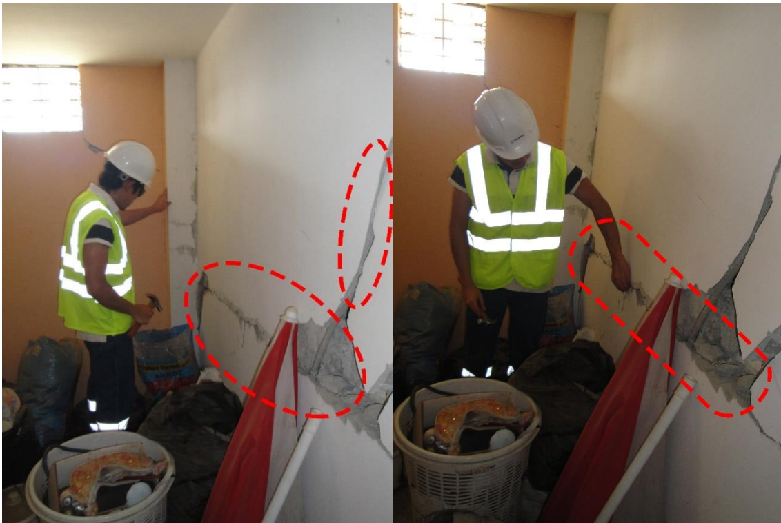
Figura 100: Paneles: Desplazamientos de las Juntas Horizontales (ENDE) – “Vivienda del Sr. Walter Santos”.
