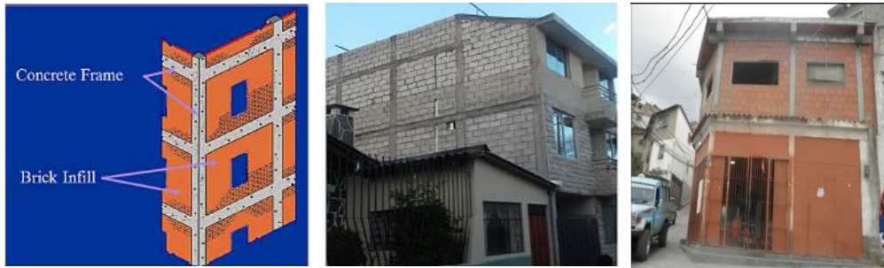
Figura 18: Pórticos de Hormigón Armado con Mampostería sin Refuerzo (C3). Fuente: (SGR - MIDUVI, 2016), (FUNVISIS, 2016).
