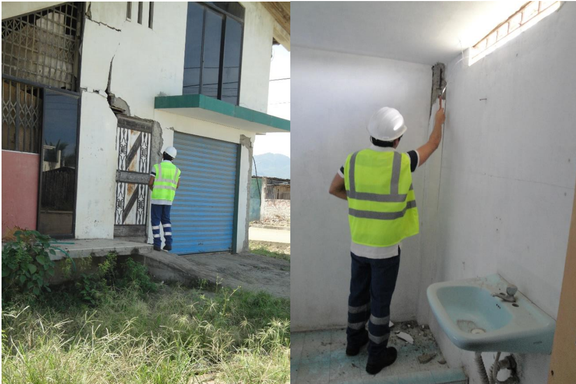
Figura 89: Inspección de las Áreas Exteriores e Interiores aplicando el Formulario (ENDE) – “Vivienda del Sr. Walter Santos”.
