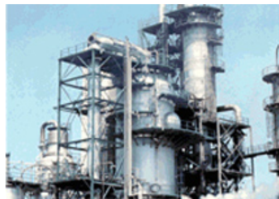
250. Planta de Petrocomercial.
