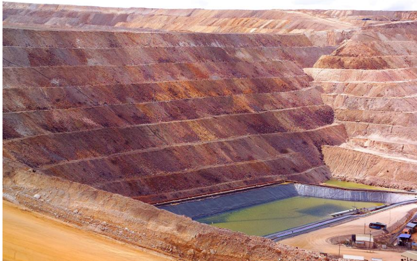
Figura 21. Lixiviación en pilas. El material fracturado se coloca formando una pila de altura definida sobre la que se coloca la solución de cianuro. Fuente: Horizonte consultores, disponible en: http://hc-srl.com.pe/index.php?id=ingenieria
