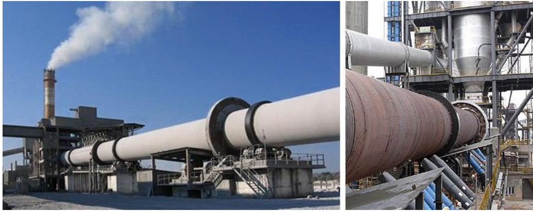
Figura 15. Hornos giratorios en una fábrica de cemento. Fuente: Mareche, disponible en: http://www.mareche.es/en/rotary-kilns-dryers/
