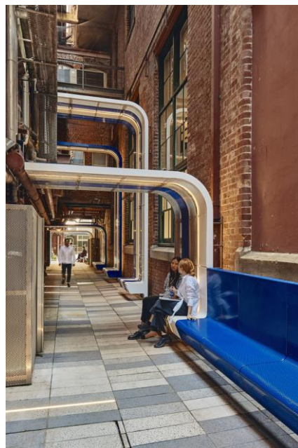
Fig 31. Bennetts, P. & Sibling Architecture. (2021). Intervención en Rodda Lane
