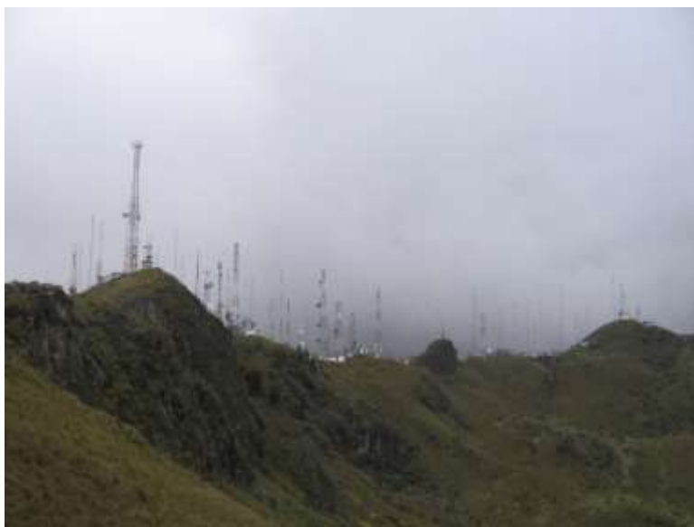
Figura No. 3: Antenas Cerro Pilisurco Fuente: Arcotel
