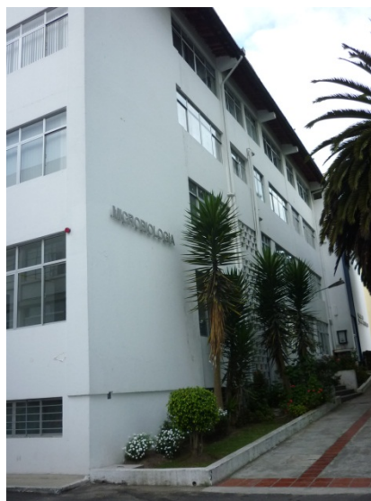
Imagen 12. Edificio Microbiología - Exterior
