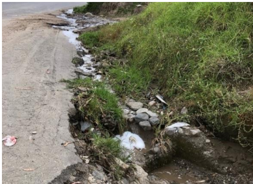
Vía de ingreso al conjunto
