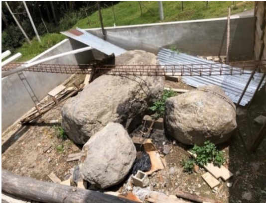
Ubicación de la planta de tratamiento
