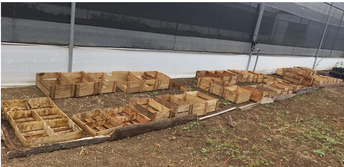
Foto 4: Construcción del vivero
