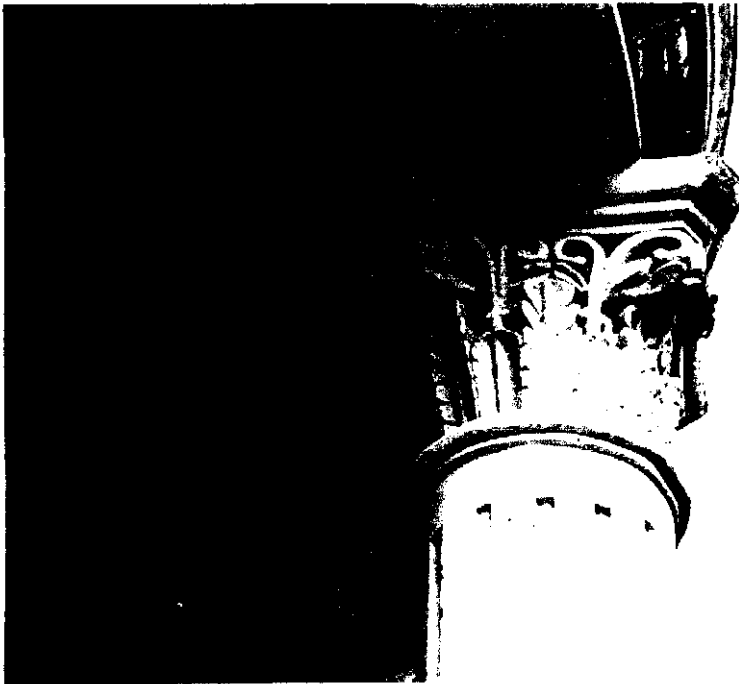
Detalle columnas exteriores
