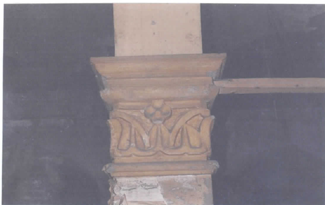
Detalle columnas interiores
