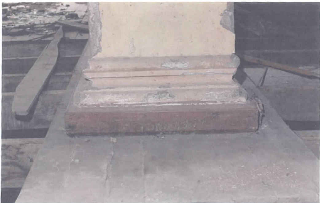
Detalle columnas interiores
