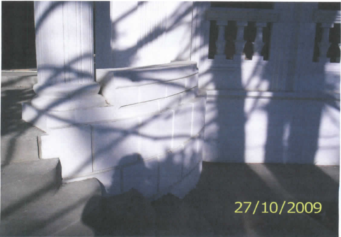
Detalle columna exterior
