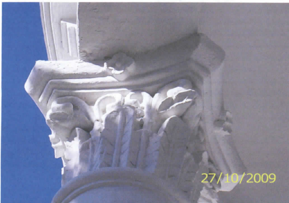
Detalle columna exterior
