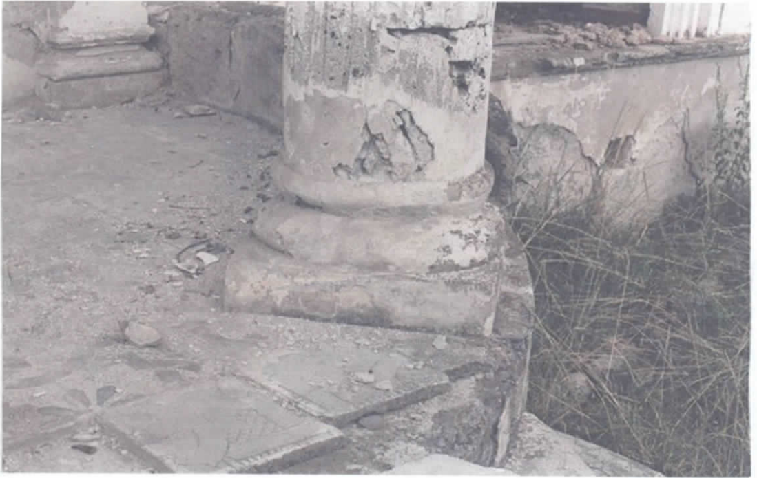
Detalle columnas exteriores
