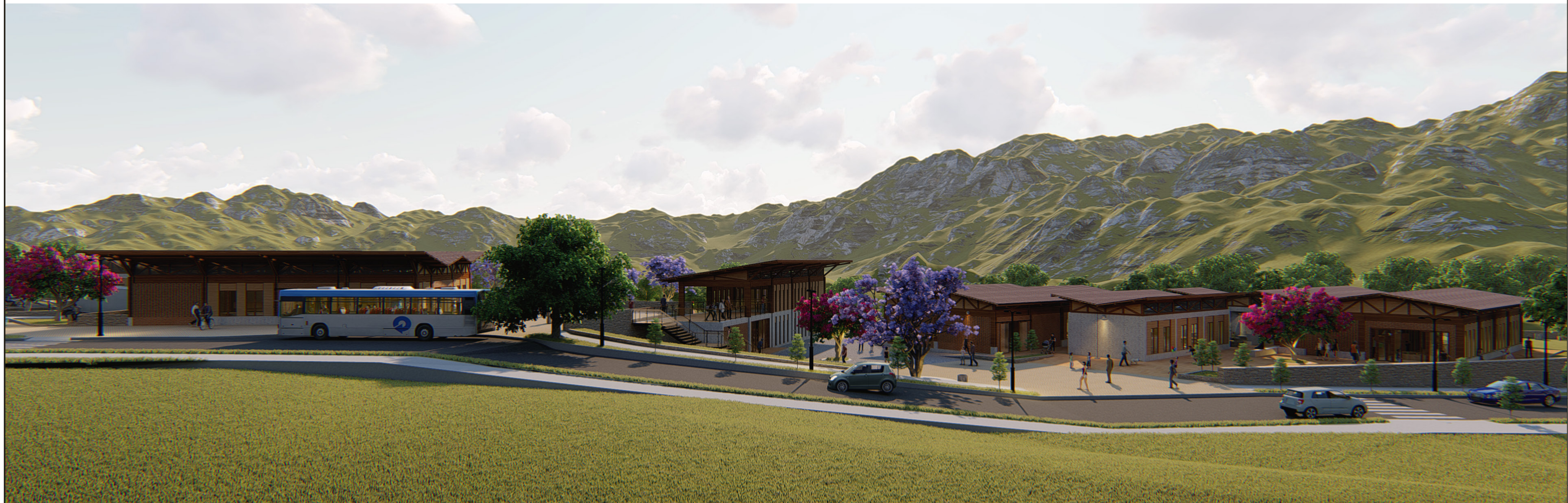
FACHADA FRONTAL: EJE VIAL
